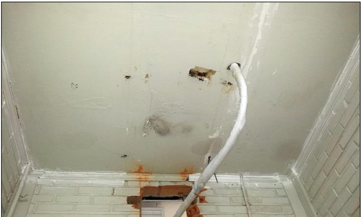
Figura 22- Teto de gesso com infiltração. Fonte: Arquivo pessoal.
