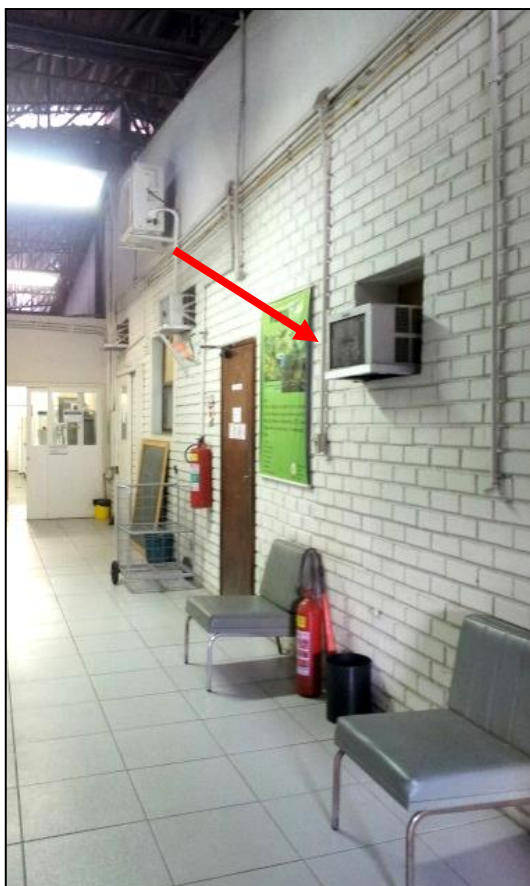
Figura 18- Aparelhos de ar condicionado mal-instalados. Fonte: Arquivo pessoal.
